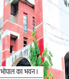
बीडीए भोपाल का भवन।
